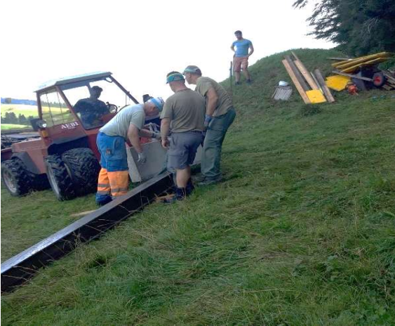
Schienen schleifen und montieren
