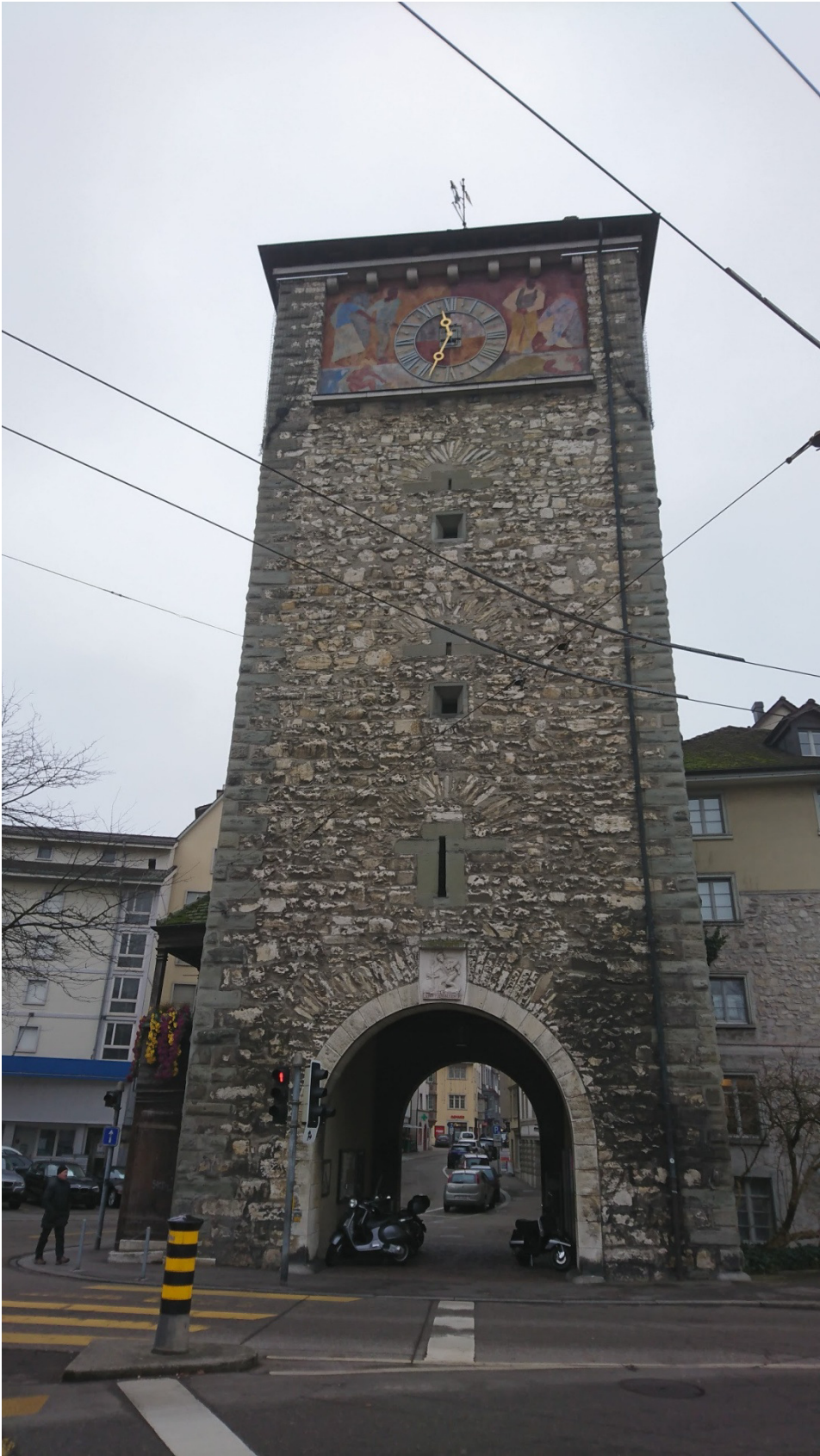
Das Schwabentor von 1361 In der Altstadt von Schaffhausen
